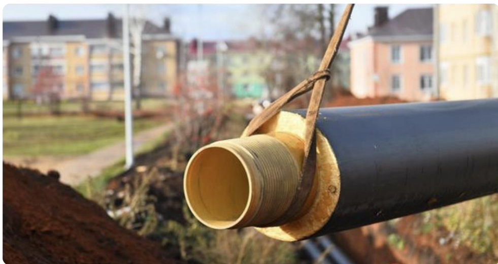
Модернизация тепловых сетей в п.г.т. Актюбинский – рабочая температура до +115 °С
